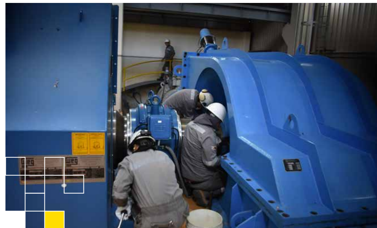
Culminación del ajuste realizado al rodete Pelton de la Unidad COR 5, durante el Mantenimiento Mayor de la Central Hidroeléctrica Corani
