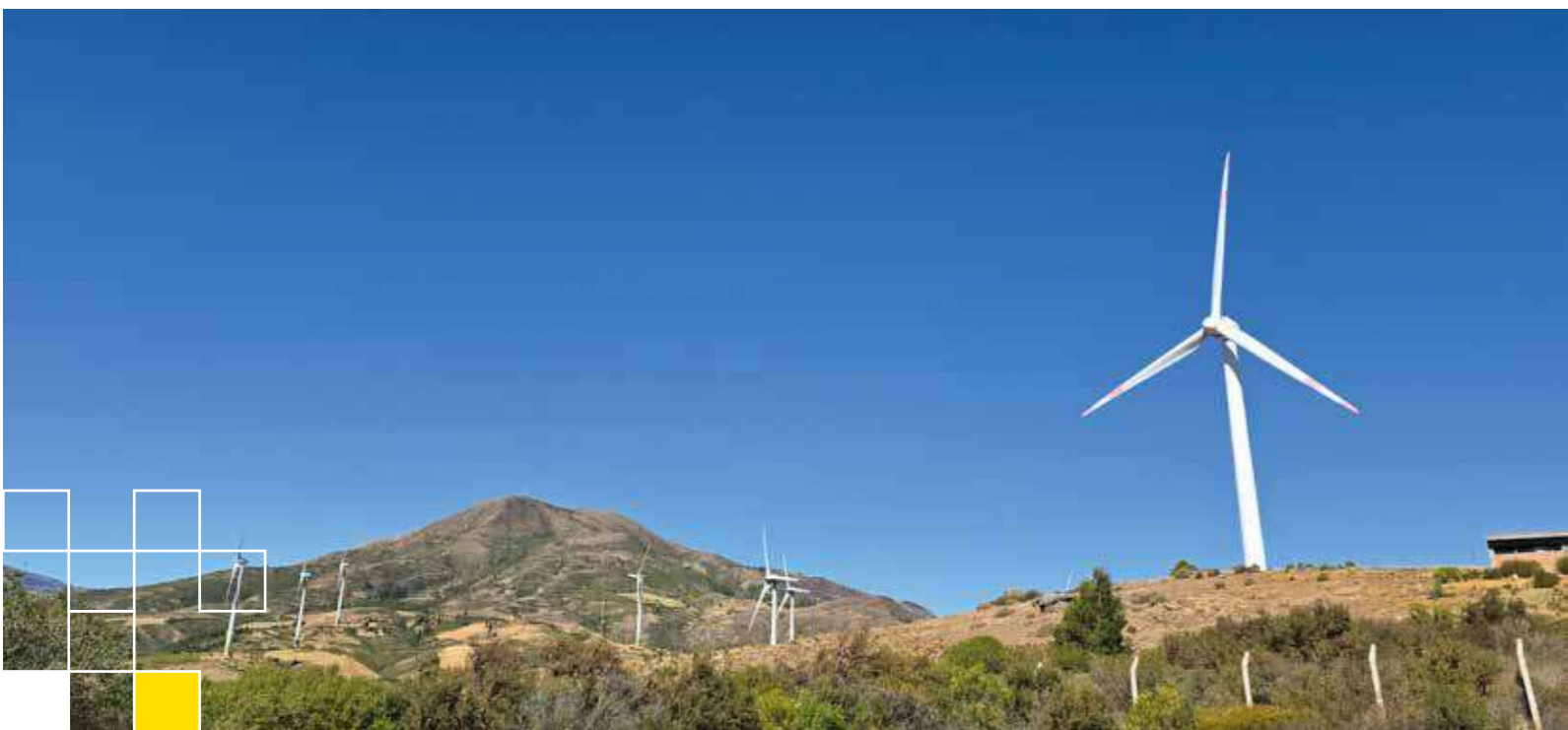
Aerogeneradores de las fases I y II del Parque Eólico Qollpana
