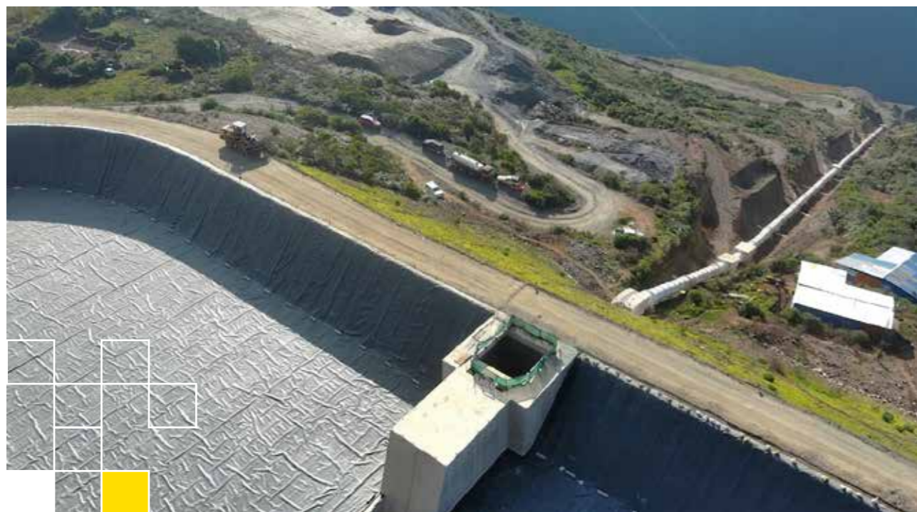
Salida de la cámara de carga e Inicio de la tubería forzada del Sistema Umapalca – Proyecto Hidroeléctrico Miguillas
