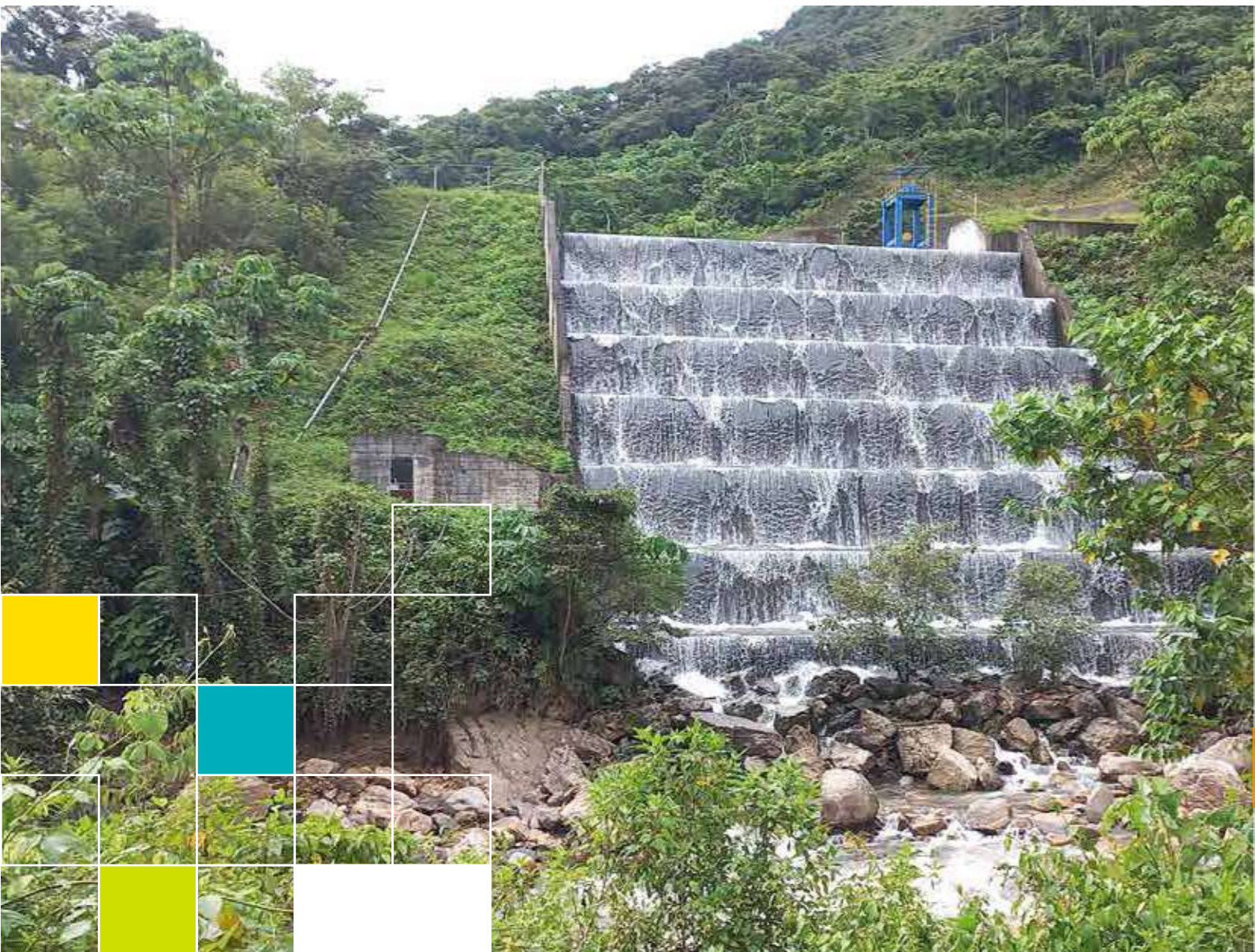
Descarga del vertedero del embalse de compensación Miguelito - Central Hidroeléctrica San José 2
