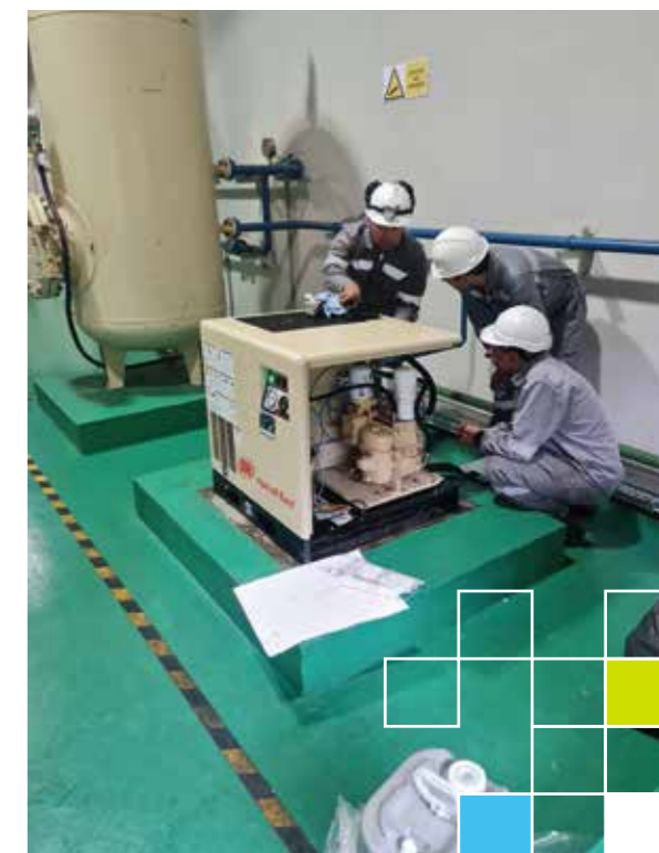
Mantenimiento del compresor de aire en la Central Hidroeléctrica San José 2
