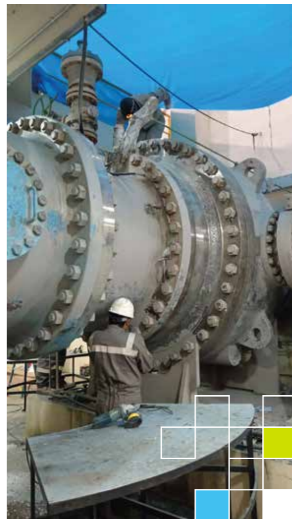
Pintado de válvula esférica de la Unidad 2 - Central Hidroeléctrica San José 1
