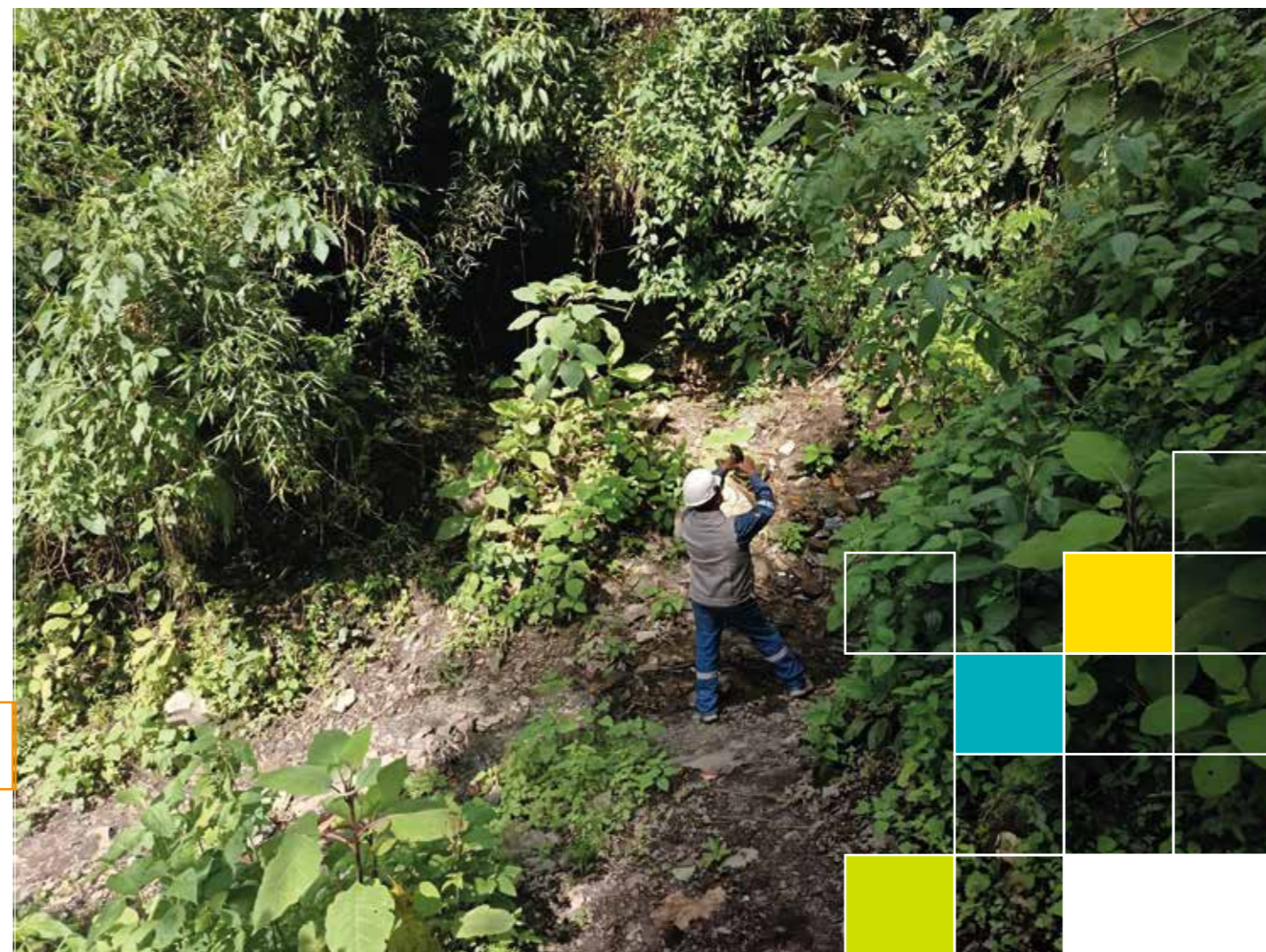
Análisis de la estabilidad de los taludes en estaciones geomecánicas - Proyecto Hidroeléctrico Icona
