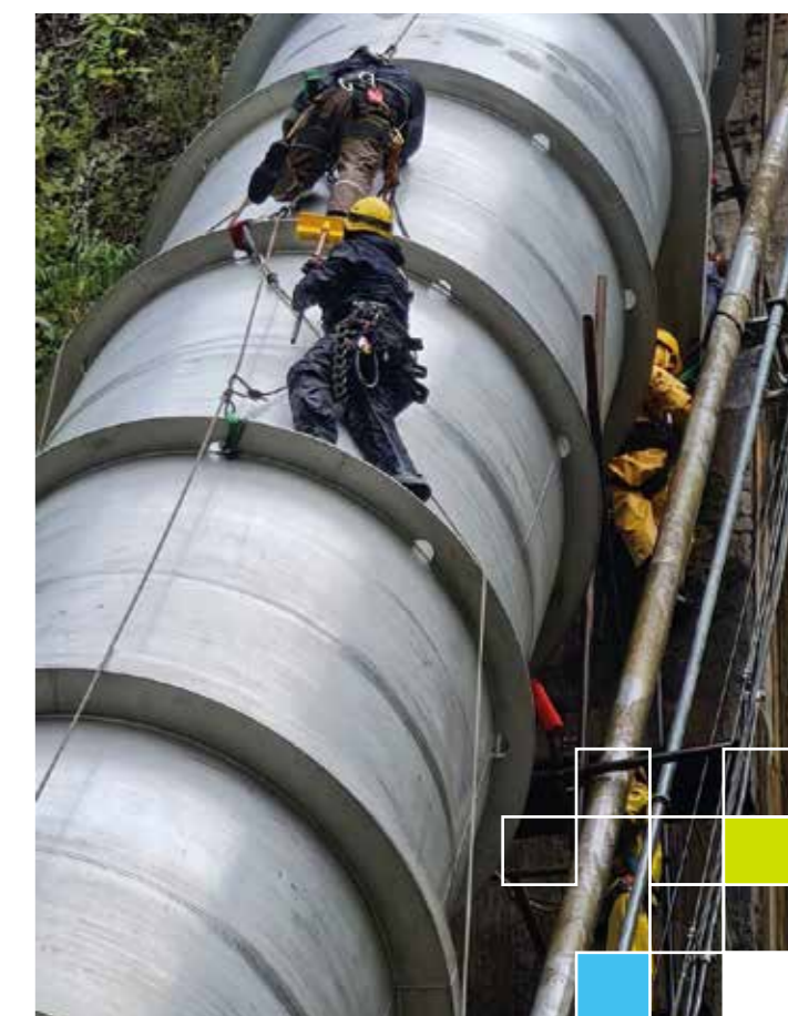
Mantenimiento de la tubería forzada de la Central Hidroeléctrica San José 2
