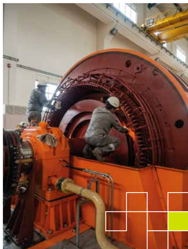
Limpieza de bobinas del generador, realizada durante el Mantenimiento Mayor de la Central Hidroeléctrica Misicuni
