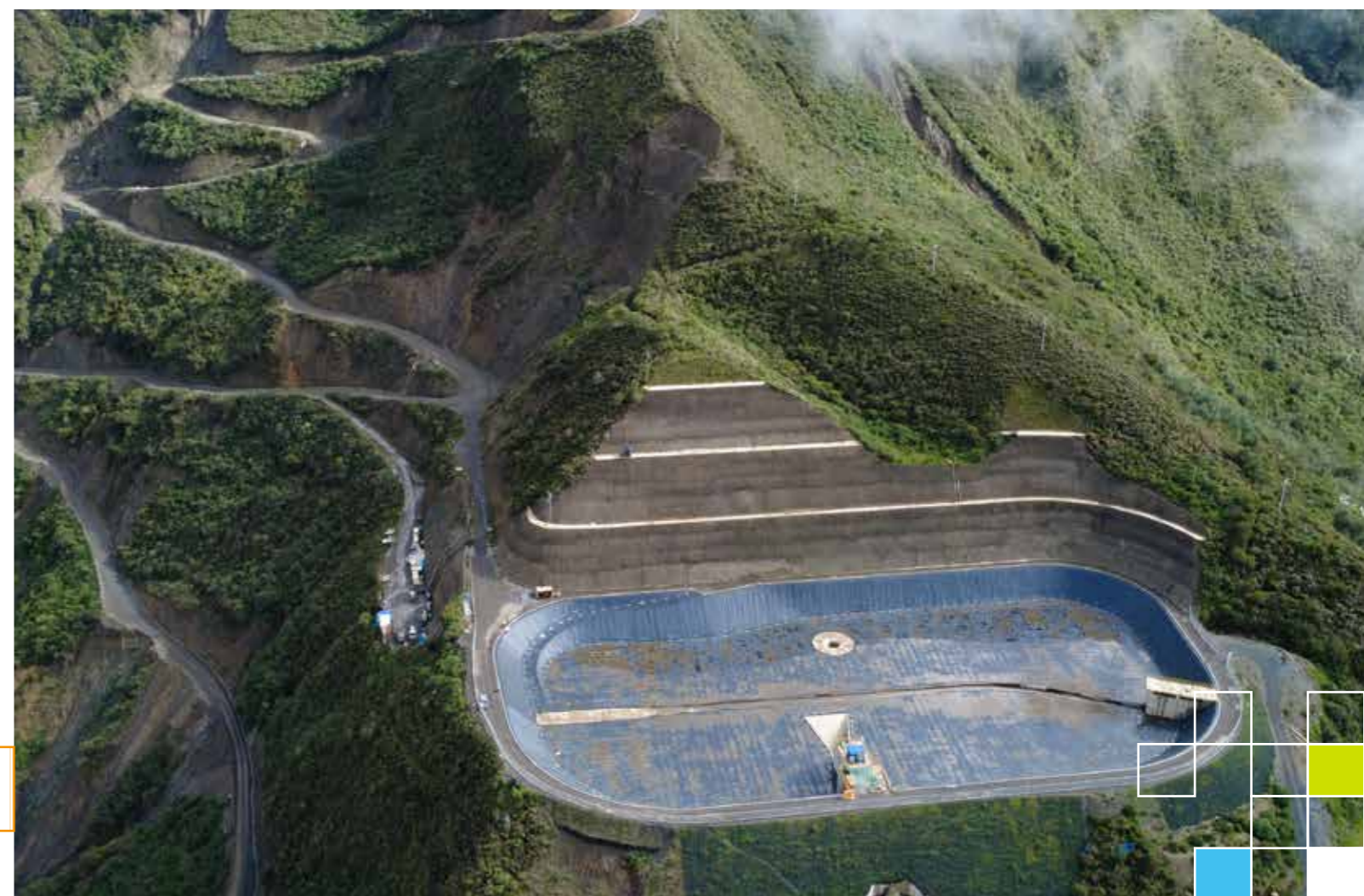
Vista aérea de la Cámara de Carga Umapalca - Proyecto Hidroeléctrico Miguillas
