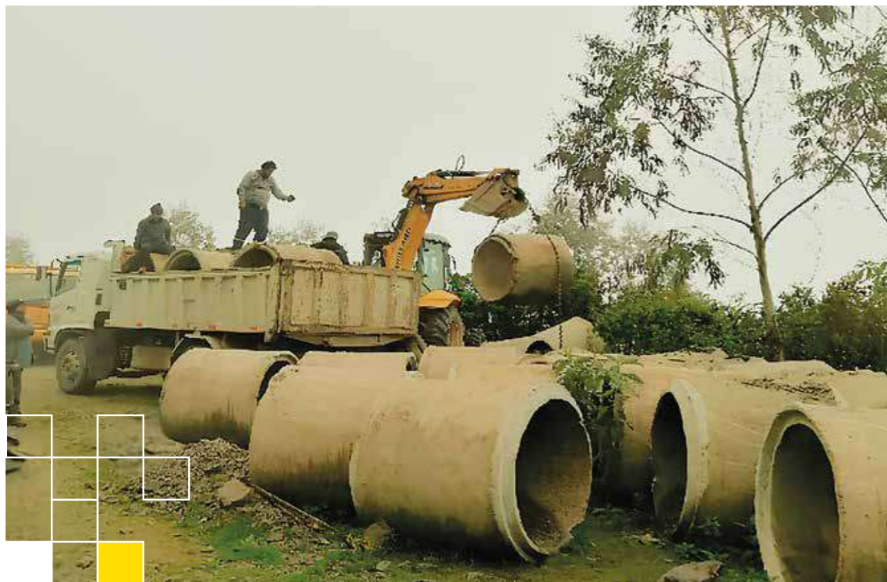
Dotación de anillas de hormigón a la comunidad 1° de Mayo del municipio de Colomi, para la construcción de un puente de hormigón armado con contraparte del Gobierno Autónomo Municipal de Colomi
