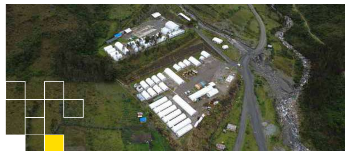
Vista aérea del campamento de trabajadores ubicado en la localidad de Choquetanga, que alberga al personal de ENDE, ENDE CORANI S.A. y la Supervisión del Proyecto Hidroeléctrico Miguillas
