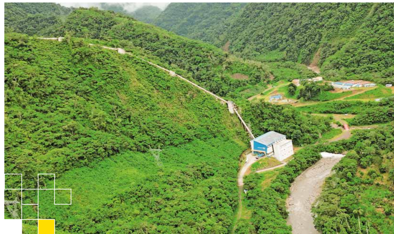
Vista aérea de la Central Hidroeléctrica San José 2
