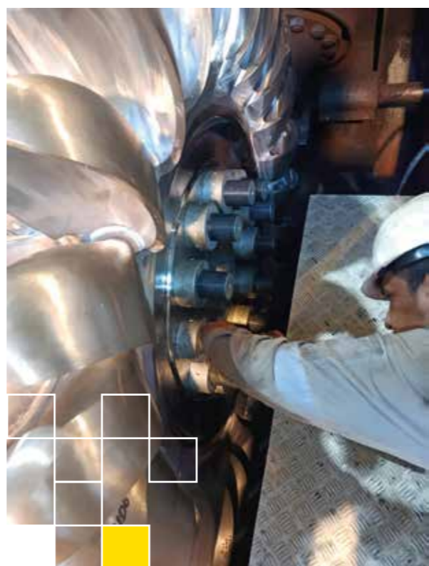
Mantenimiento de rodete Pelton en la Central Hidroeléctrica Santa Isabel
