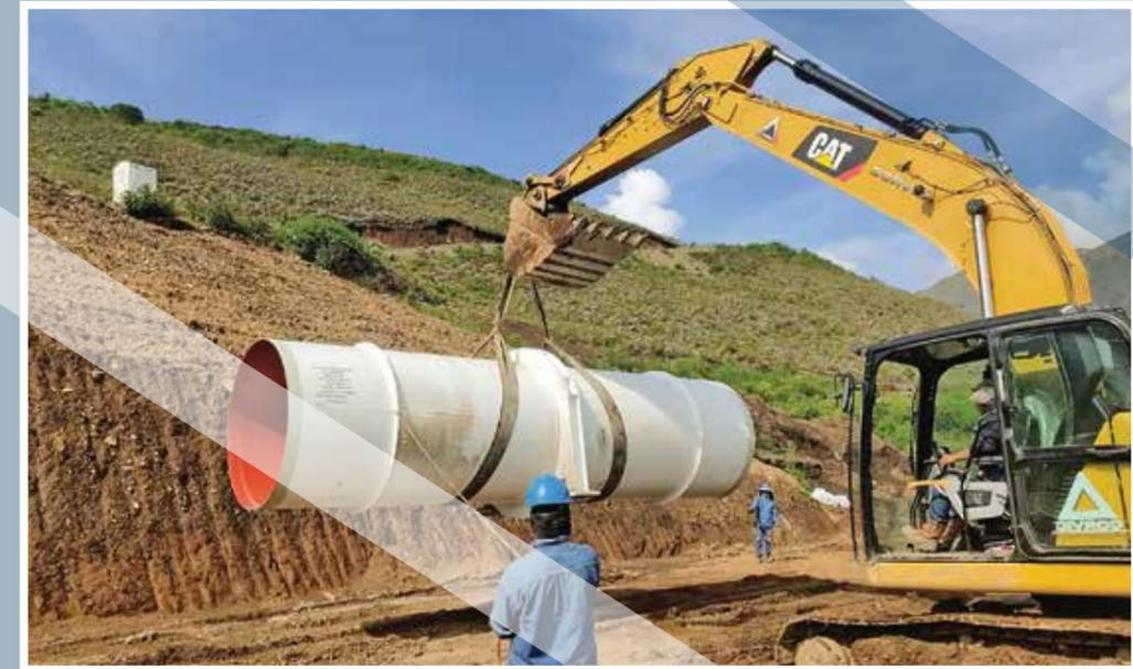
Montaje tubería forzada sistema Umopalca (tramo de pendiente baja)
