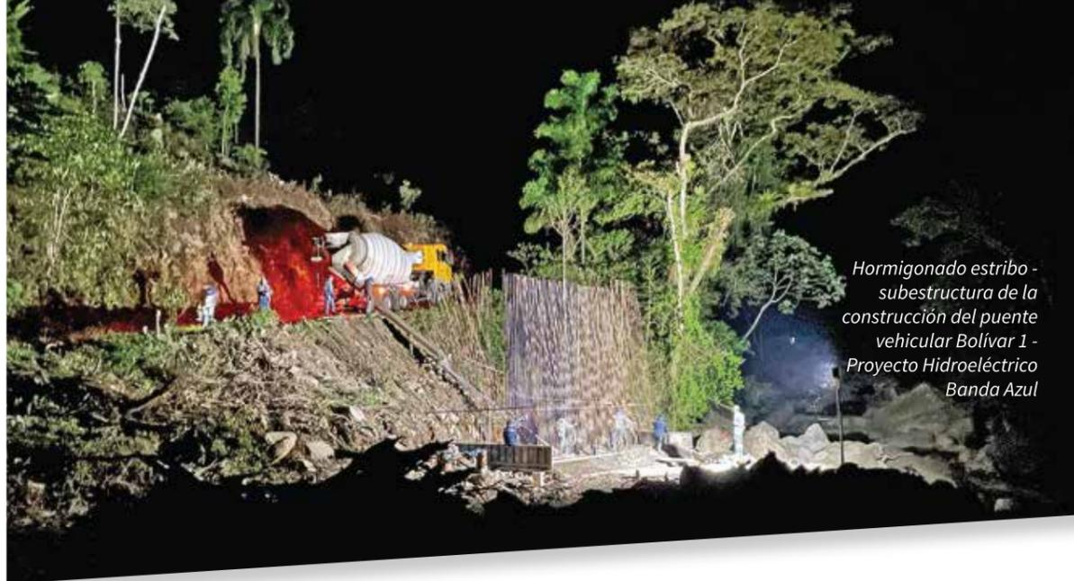
Hormigonado estribo - subestructura de la construcción del puente vehicular Bolívar 1 - Proyecto Hidroeléctrico Banda Azul
