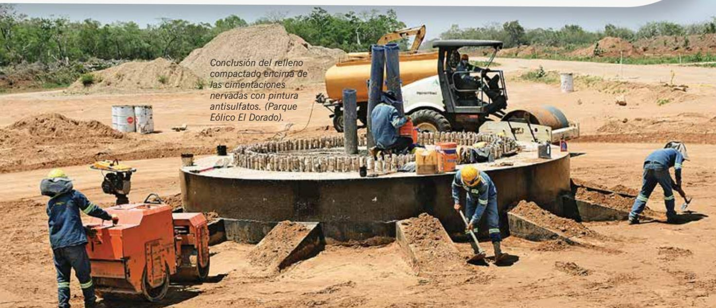
Conclusión del relleno compactado encima de las cimentaciones nervadas con pintura antisulfatos. (Parque Eólico El Dorado).
