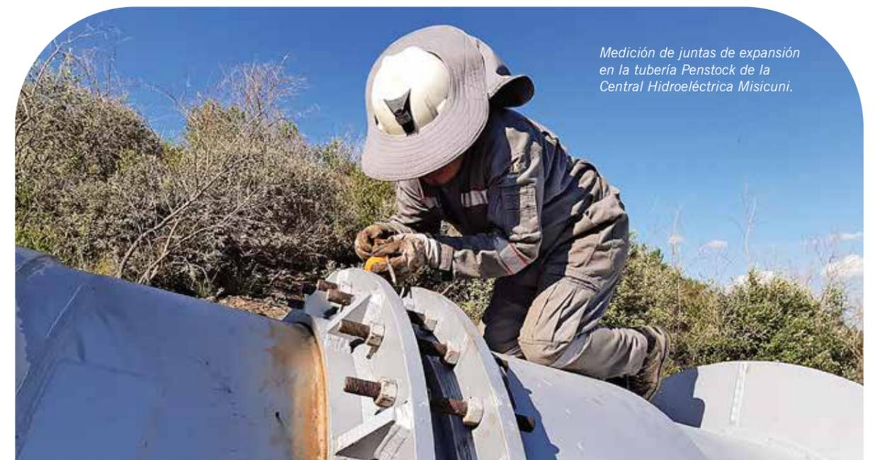
*Medición de juntas de expansión en la tubería Penstock de la Central Hidroeléctrica Misicuni.*
