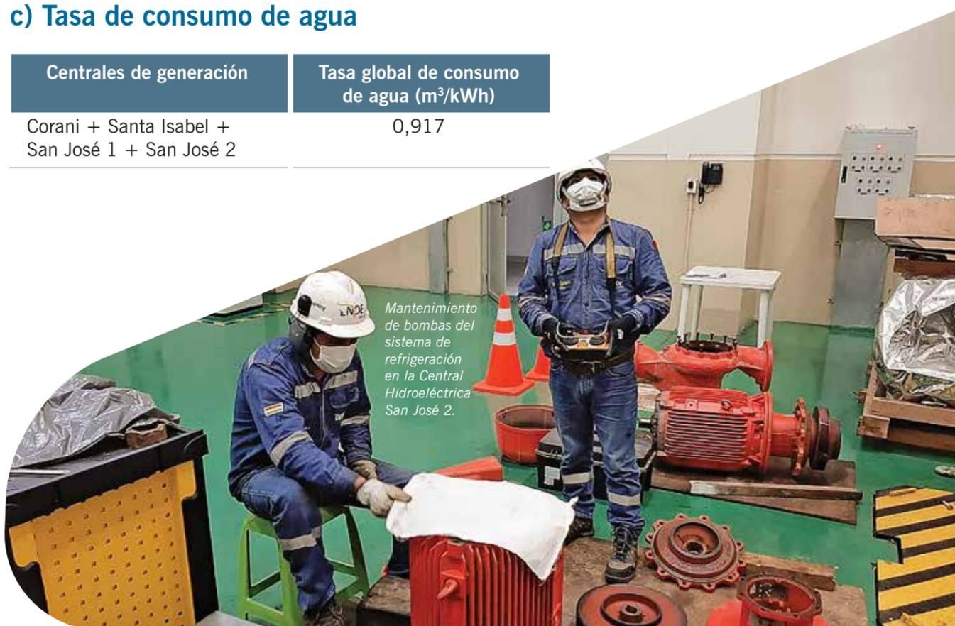
Mantenimiento de bombas del sistema de refrigeración en la Central Hidroeléctrica San José 2.
