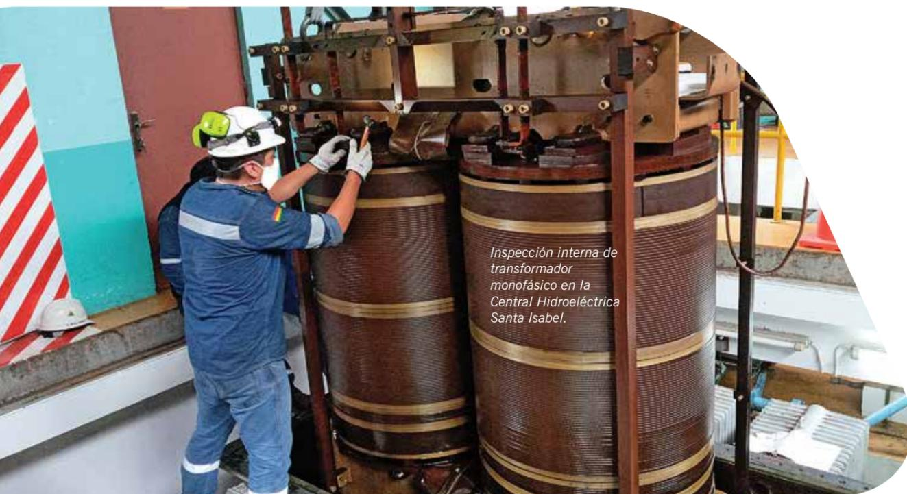
Inspección interna de transformador monofásico en la Central Hidroeléctrica Santa Isabel.
