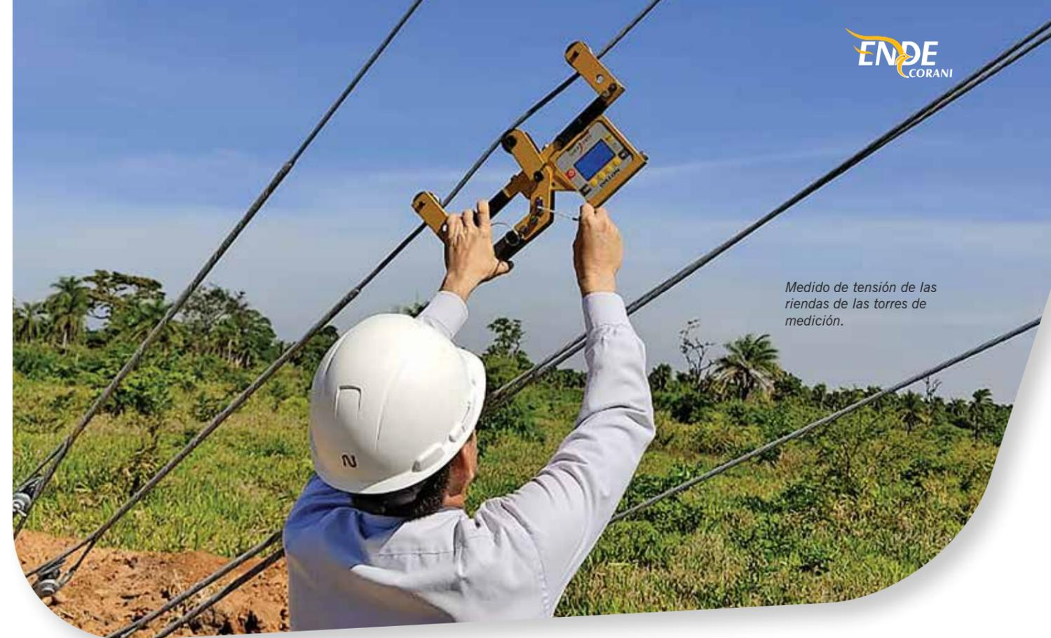
Medido de tensión de las riendas de las torres de medición.
