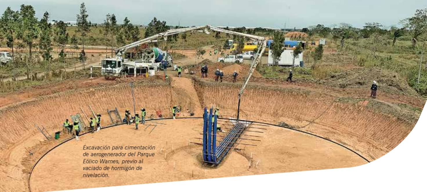
Excavación para cimentación de aerogenerador del Parque Eólico Warnes, previo al vaciado de hormigón de nivelación.
