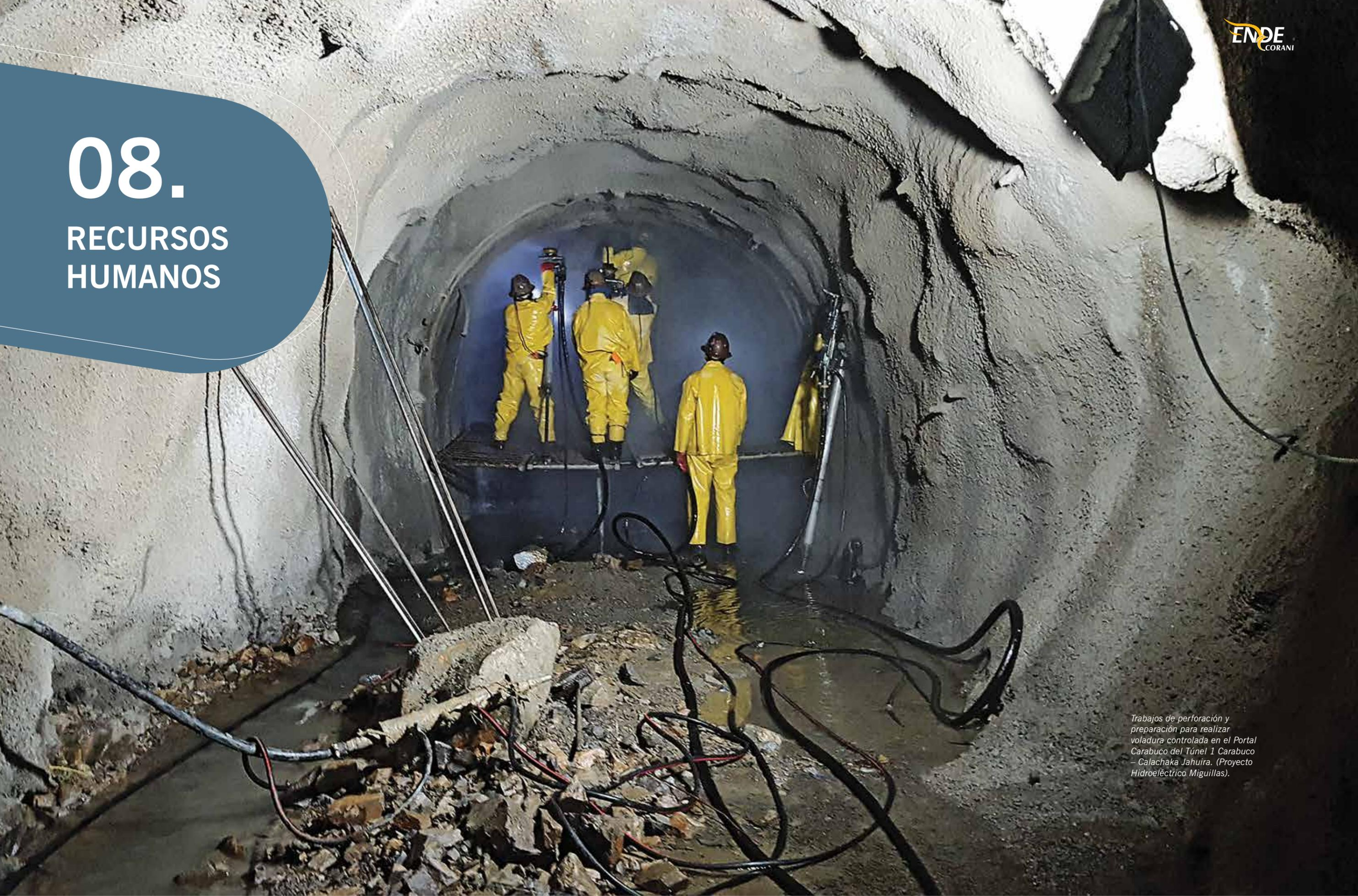
*Trabajos de perforación y preparación para realizar voladura controlada en el Portal Carabuco del Túnel 1 Carabuco – Calachaka Jahuira. (Proyecto Hidroeléctrico Miguillas).*
