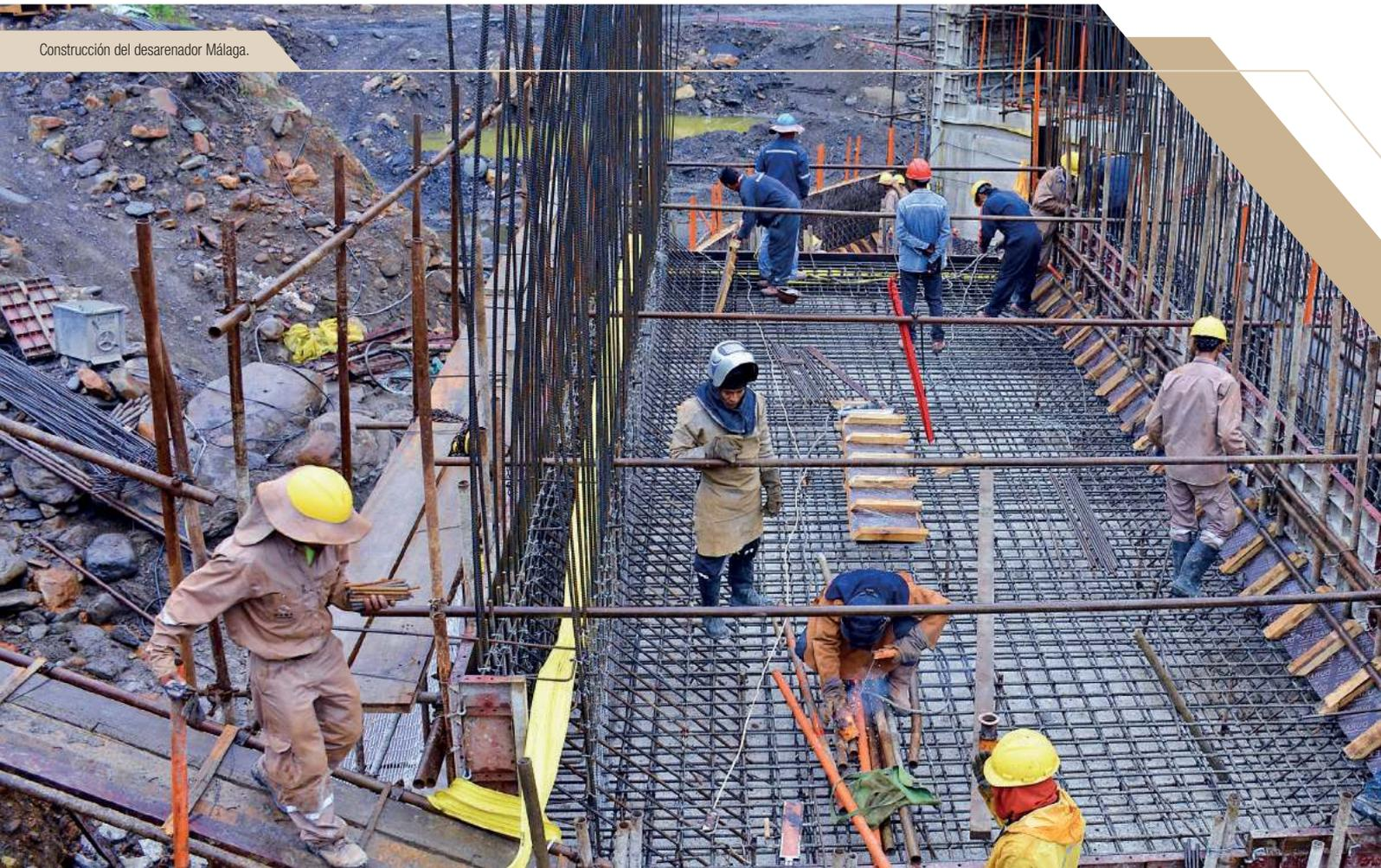
En cuanto a la toma Ronquito, se realizaron estructuras de hormigón armado para el muro encauzador izquierdo, el canal de conducción y el muro de contención transversal al canal de conducción. En la toma Málaga se realizó el hormigonado de muros encauzadores, además de su excavación y nivelado.
